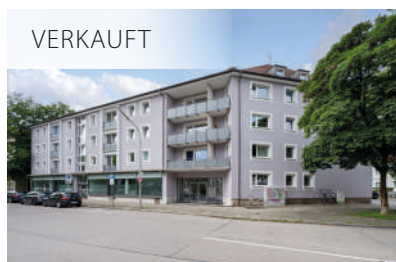
Pasing – Saniertes Mehrfamilienhaus, ca. 2.330 m 2 vermietb. Fläche, 1.021 m 2 Grund, Bj. 1960
