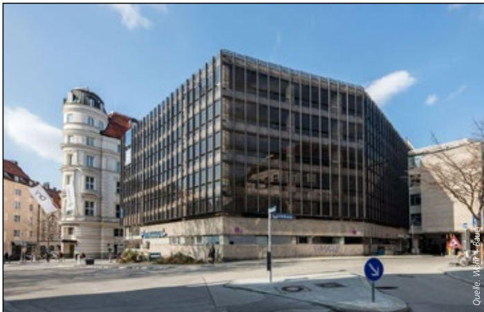
Koloss in der Altstadt: Die ehemalige Hochgarage an der Hildegardstraße
