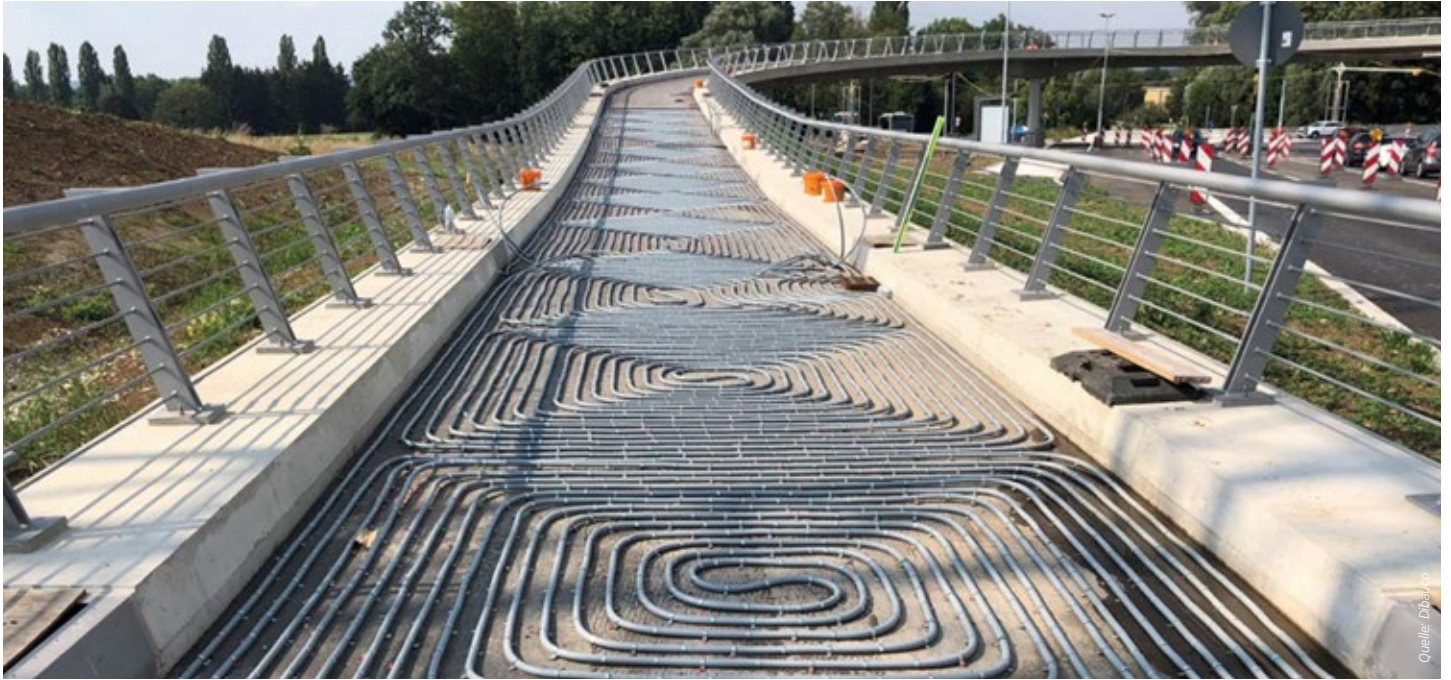
Wenn der Automobilkonzern Audi in Ingolstadt Brücken bauen will, die mit Industrierwärme von einem Motorenprüfstand beheizt werden, ist Dibaucó beratend mit dabei
