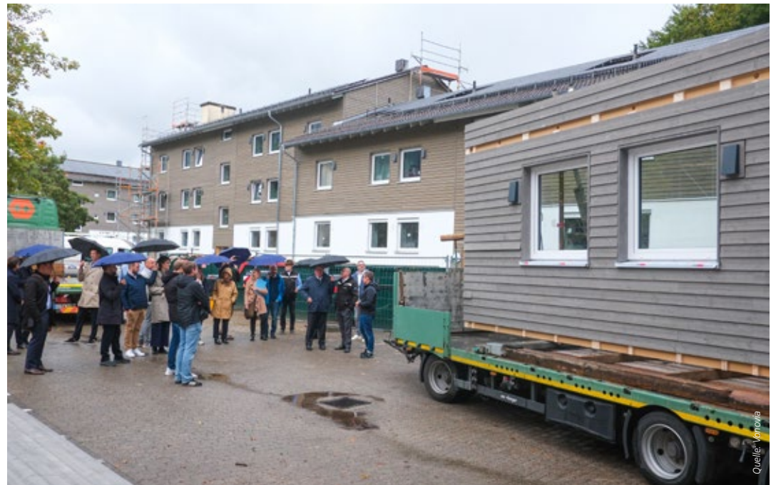
Vom Lkw-Anhänger an die Wände: 3,05 mal 9 Meter große Module für modernes, energiesparendes Wohnen
