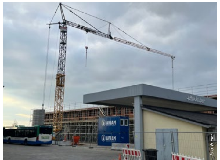
Noch ist der Bus-Carport für die Firma Ettenhuber eine Baustelle. Aber sie kommt schneller voran als gedacht
