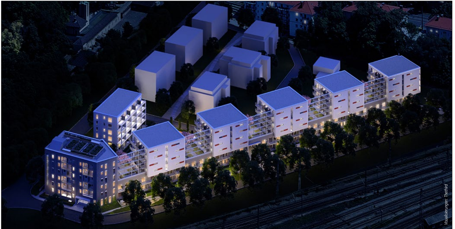
309 Wohnungen, 12 000 m 2 Wohnfläche, Mieten knapp unter 20 Euro/m 2 : Die Wohnanlage Augusta an der Ladehofstraße am Hauptbahnhof
