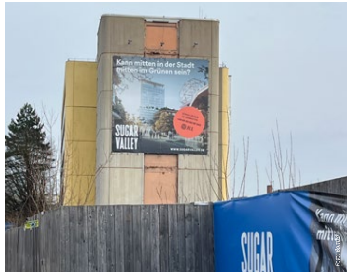
Die Tage des Gebäudes Boschetsrieder Straße 129 sind gezählt. An dieser Stelle ist ein 80 Meter hoher Büroturm geplant
