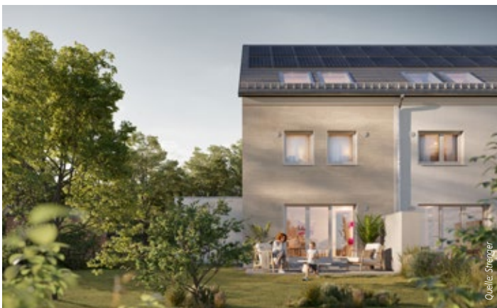
Zu jedem Haus gehören eine Terrasse und zwei Autostellplätze
