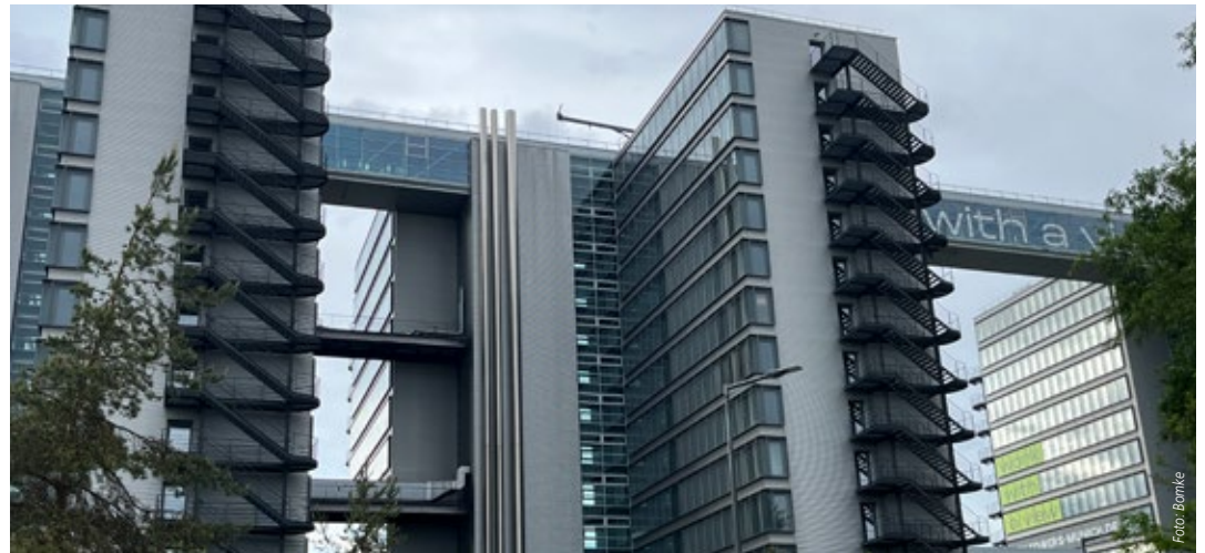
Ten Towers: Alleinstellungsmerkmal Verbindungsgänge auf Stock 14
