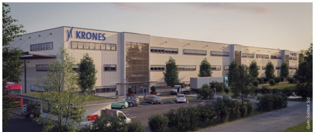
In Bad Aibling baut Goldbeck für Bauherr Retis 18 000 Quadratmeter, die Krones 2027 beziehen wird
