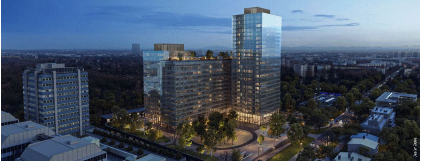
Der Bürocampus Tridea der BVK in Bogenhausen zählt derzeit zu den spektakuläreren Baustellen in München
