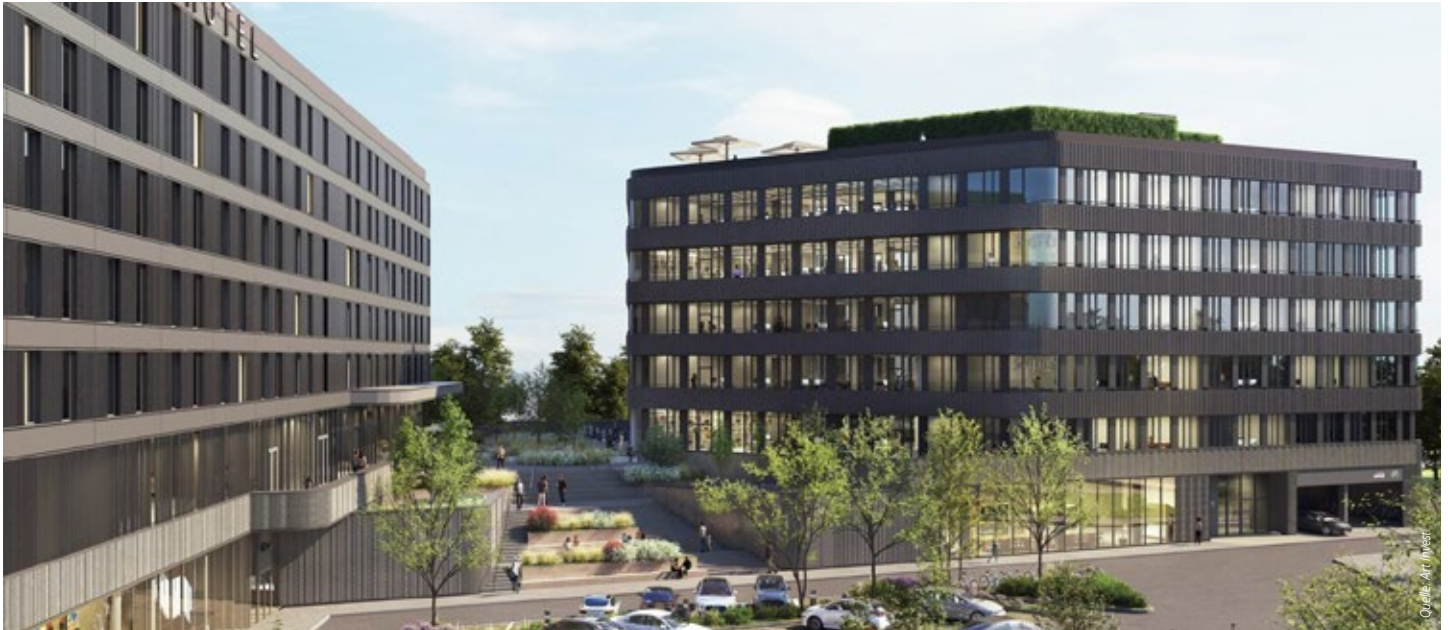
Anfang 2028 bezieht der Rüstungskonzern Hensoldt seinen neuen Hauptsitz an der Ludwig-Bölkow-Allee in Taufkirchen
