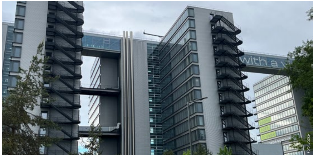
Referenzprojekt für Umbauten von Büros zu Wohnungen: Die „Ten Towers“
